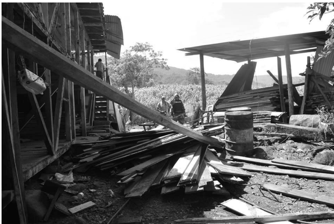
Casas totalmente destruidas sin un procedimiento adecuado de desalojo durante los desalojos forzosos de Septiembre de 2015.
